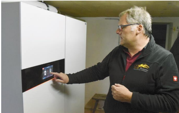
Andreas Klein nimmt selbst die Endkontrolle der neuinstallierten VISSMANN-Brennstoffzelle ab.
